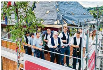
Tradition: Mit Richtspruch und Richtbaum haben die beteiligten Handwerker den fertigen Rohbau übergeben.
